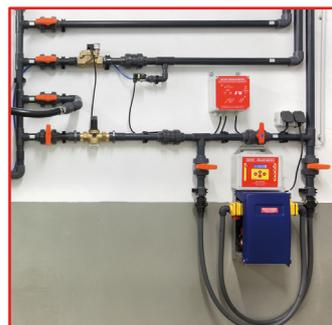
Elektrischer Medikamentendosierer zum Eindosieren von Säuren zur pH-Wertreduzierung und zum Medikamenteneinsatz in das Trinkwasser
