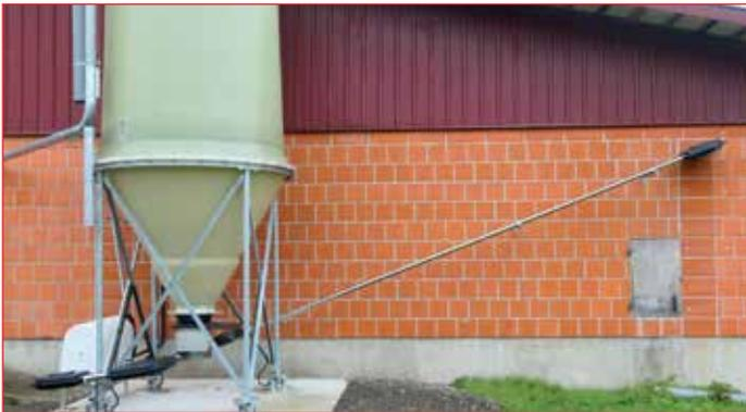
Die Pellets werden in Außen- oder Innensilos gelagert. Eine Ketten- oder motorgetriebene Futteraufnahme nimmt die Pellets unter den Silos auf.
