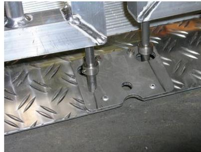
Einstellung Türöffner: Tor schließen, Mutter unter dem Griff so verschieben, dass die Türöffner-Stange so weit unten wie möglich das schräge Bodenblech erreicht, Mutter anschließend wieder festziehen
