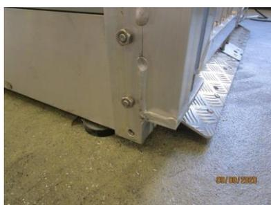
4. Seitenteile befestigen: Mit 7 Schrauben 10x60 + Muttern; je Eckpfosten 2 Stk. in die oberen 2 der 3 Bohrungen. Eckpfosten an den Ecken mit Fußpedal mit 1 Stk. 10x60 in der oberen der 3 Bohrungen und der vorher zurückgeschobenen 10x75 Schraube vom Fußpedal Alle 7 Schrauben von Innen montieren (Muttern außen)!
