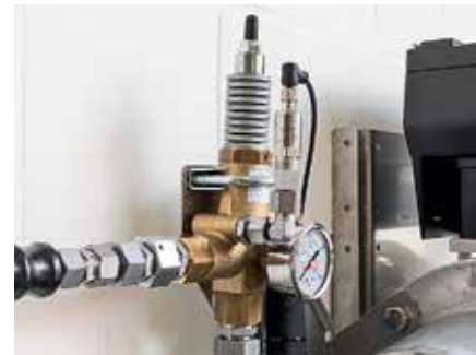
Die Kombination aus Steuerung und einem sensibel reagierenden Drucksensor (kleines Teil vorne) macht das Arbeiten komfortabel.
