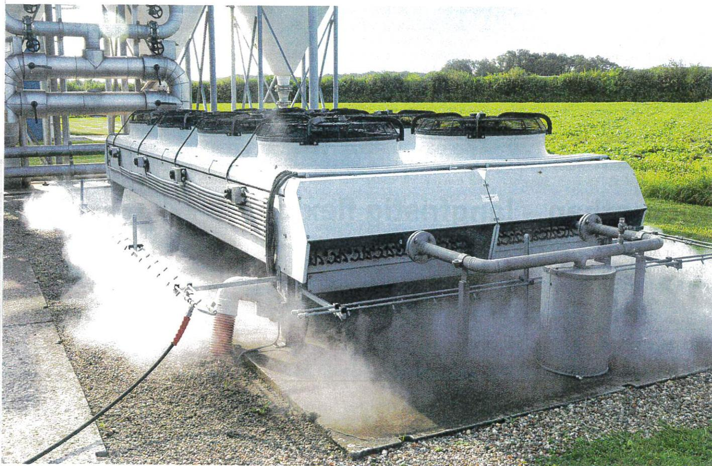
△ Die Düsen rund um den Tischkühler versprühen einen feinen Wassernebel. Das kühlt die Luft.
