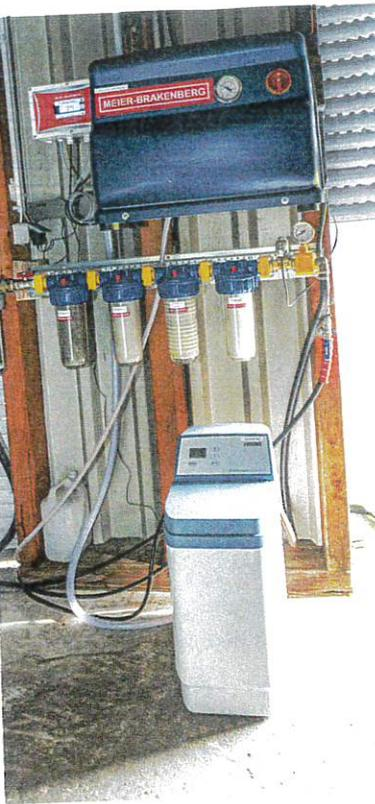
◁ Zu dem Hochdruckkühlsystem von Meier-Brakenberg gehören die Pumpenstation mit vorgeschalteter Filtereinheit und Entkalkung sowie ein Bediencomputer für die Steuerung der Anlage.
