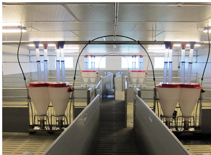
Bild 6 Direkte Verbindung der Futterautomaten mit Umlauftränkeleitung über PE-Rohr
