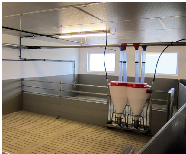
Bild 5 Futterautomat in Umlauftränkeleitung integriert
